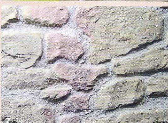
**1** Vyměříme si obkládanou plochu a přímočarou pilou příznamě panely na požadovaný rozměr (použijeme list na řezání polyesteru/skloaluminátu). Alternativně můžeme řezat i ruční okružní pilou s diamantovým kotoučem.
